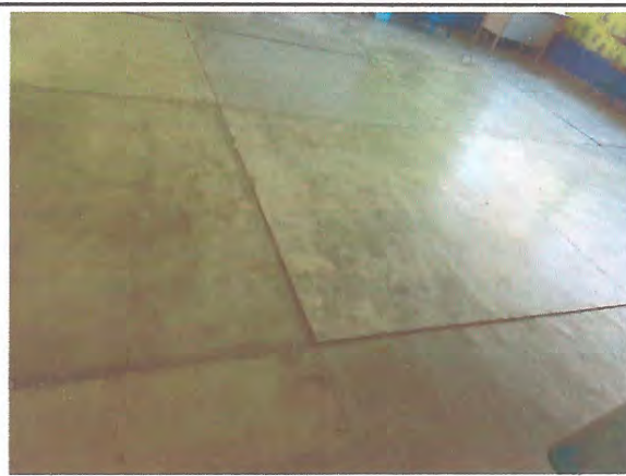
Foto 4: REMOZAMIENTO DE PISOS DAÑADOS
