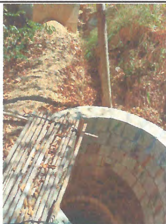
Foto 3: REPARACIÓN DE FOSA SÉPTICA DEBIDO A QUE ESTA POR COLAPSAR
