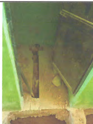
Foto 2: REMOZAMIENTO DE SISTEMA DE TUBERÍA DE DRENAJE QUE SE DIRIGE A LA FOSA SÉPTICA
